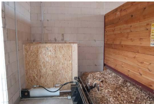
Bild 5: Förderschnecke
