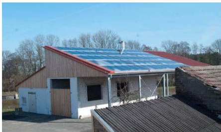
Bild 6: Solarthermie-Außenanlage
