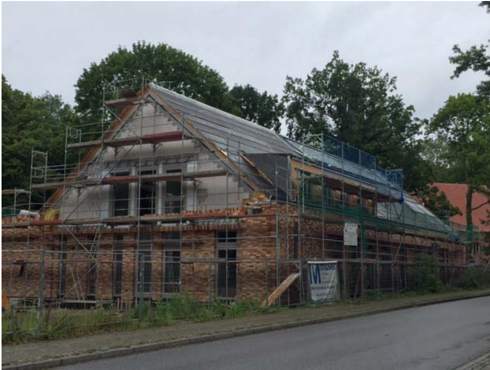
Foto des Neubaus, auf dessen Gauben eine PV-Anlage geplant ist, © Cornelia Behm 2017.
