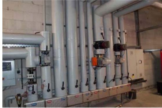
Links: Heizhaus und Hackschnitzel-Lager, rechts: Vor- und Rücklauf-Leitungen, Fotos © Baitzer Heizer eG
