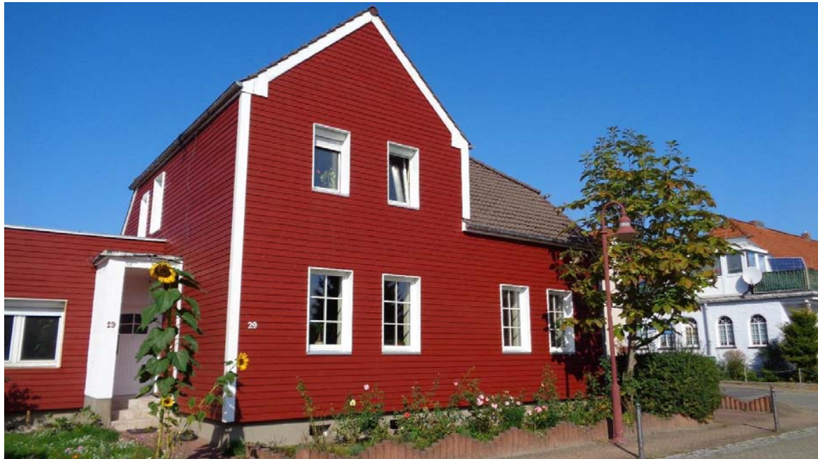
Frontansicht mit 12 cm ökologischer Wärmedämmung; alle Fotos © Schiller
