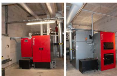
Bild 9: Kleiner Kessel und Aschebehälter
